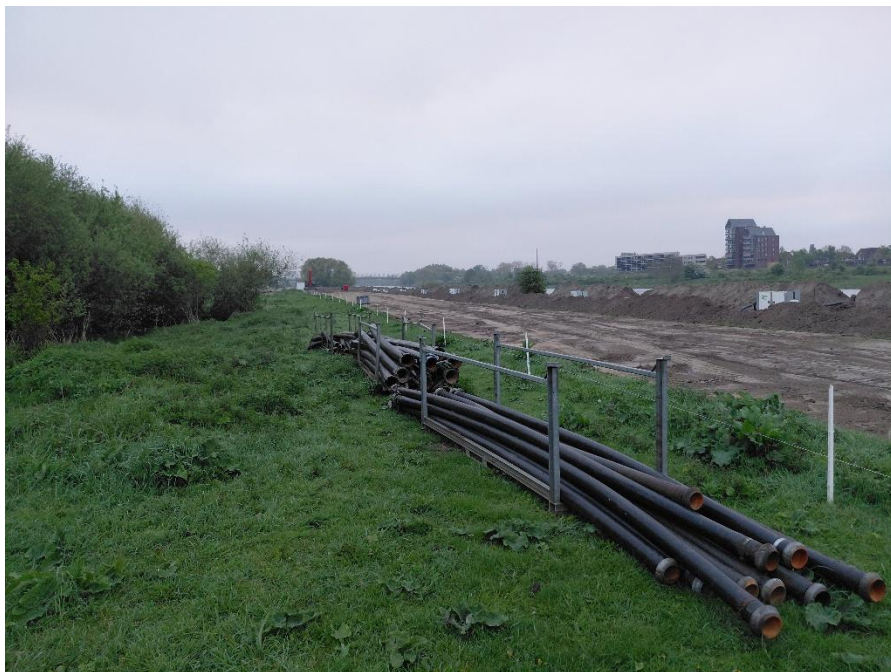
Impressie telgebied Romeinenweerd met zicht op de werkzaamheden. Foto's: Vincent de Boer.
