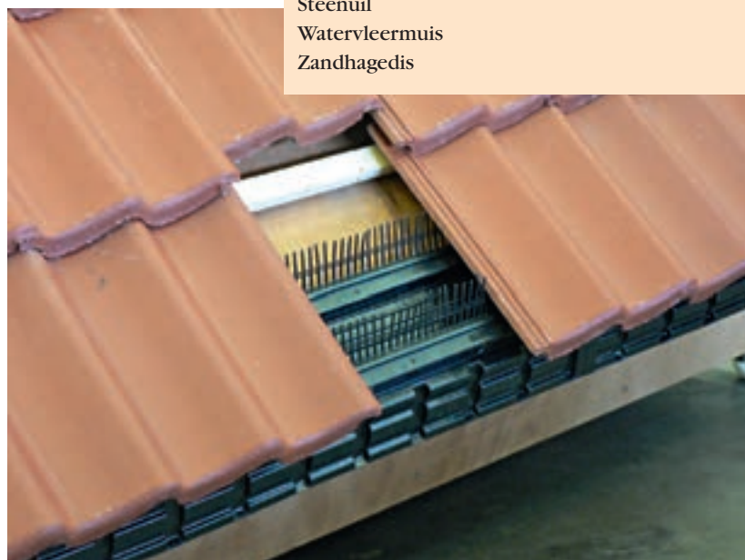
Vogelvide verwerkt in het dak (bron: Monier B.V. – Montfoort).
