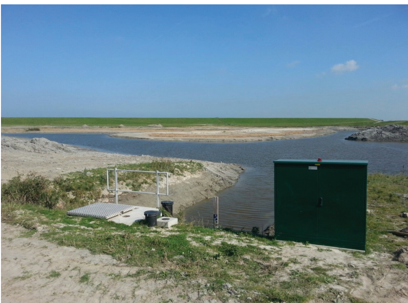
Foto 2. Pompgemaal dat zorgt voor het pompen van zoutwater uit de oostelijke waterplas in het nieuwe westelijke gedeelte (Arjan Hendriks).
