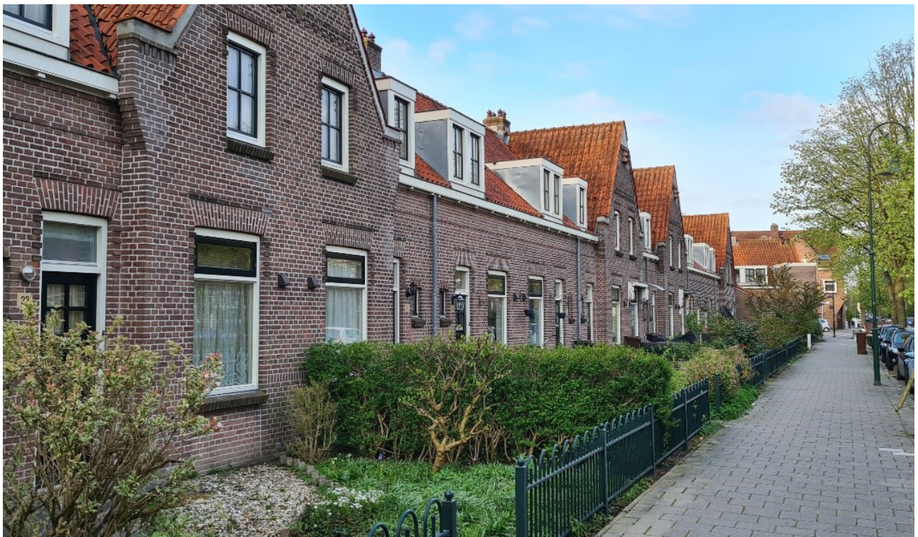
Straatbeeld in de Lessepsstraat. Voorzieningen voor de Huismus zijn aangebracht onder de dakrand (vanaf de straat niet zichtbaar).
