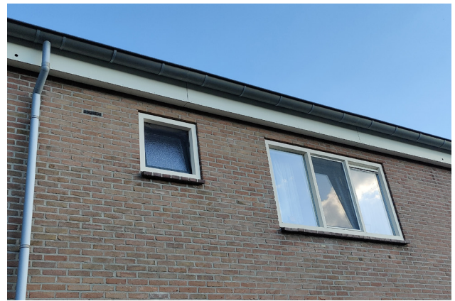
In Boskamp zijn ISO-bouw voorzieningen toegepast.
