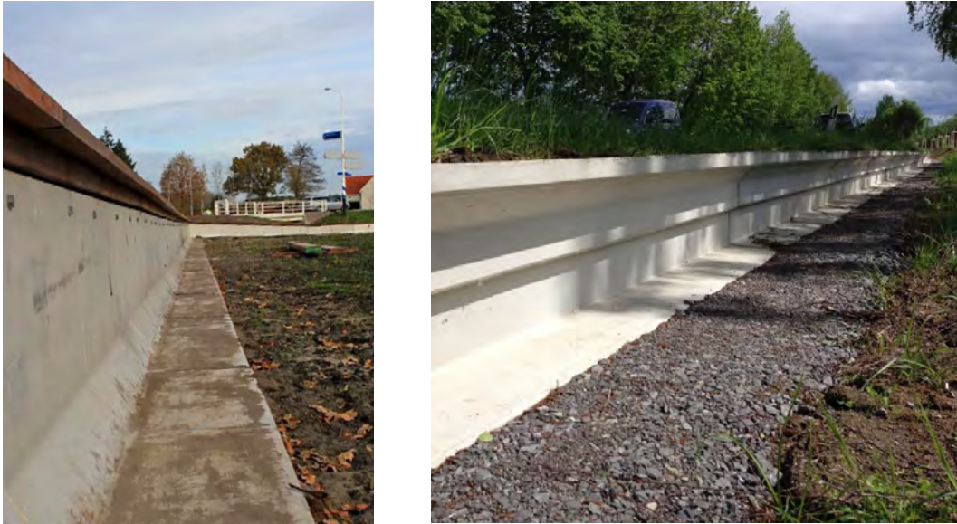
Figuur bijlage 1: Twee voorbeelden van geschikte betonnen schermen. Beide hebben aan de bovenzijde een overstekende rand om te voorkomen dat dieren over de rand kunnen klimmen en aan de voet een horizontale rand om de groei van vegetatie te voorkomen en onderhoud te vereenvoudigen (Foto's: Richard Struijk (links, Veenhuizen) en Maibach GmbH (rechts)).
