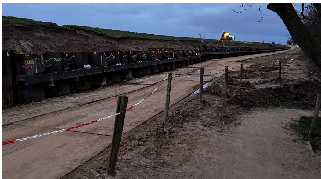
Dijkwerkzaamheden in de vroege ochtend bij Opijnen, 17 maart 2025 (Christian Brinkman)
