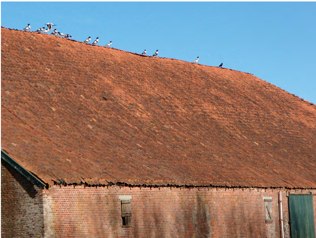
Bergeenden kunnen koloniegewijs op onverwachte plekken broeden, zoals bij/in/onder deze leegstaande en vervallen boerderij (Hongerige Wolf, 27 april 2015, Willem van Manen).
