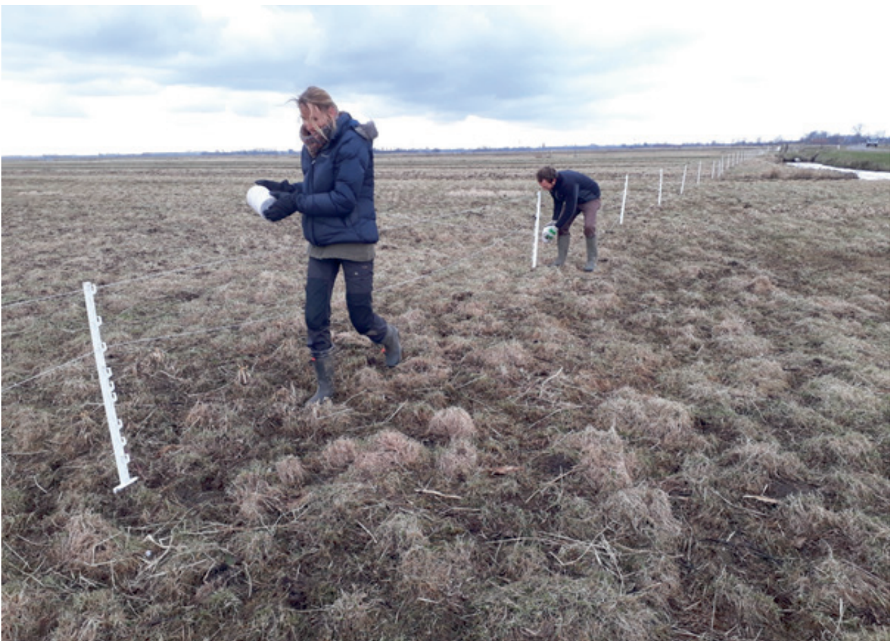
Het plaatsen van een elektrisch raster om grote zoogdieren buiten te houden
