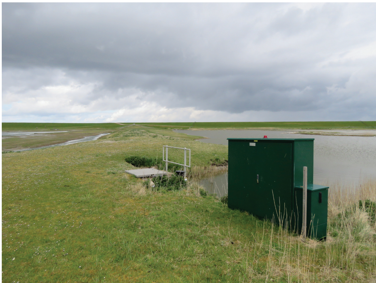
Foto 1. Pompgemaal op de 'tussendijk' in de Klutenplas, dat zorgt voor het pompen van zout (brak) water uit de oostelijke waterplas (rechts op de foto) in het westelijke gedeelte.
